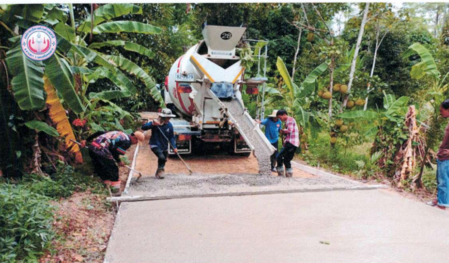
2.3 ก่อสร้างถนน คสล.สายอนามัย-นายฉลุย หมู่ที่ 5 งบประมาณเบิกจ่าย 300,000 บาท
